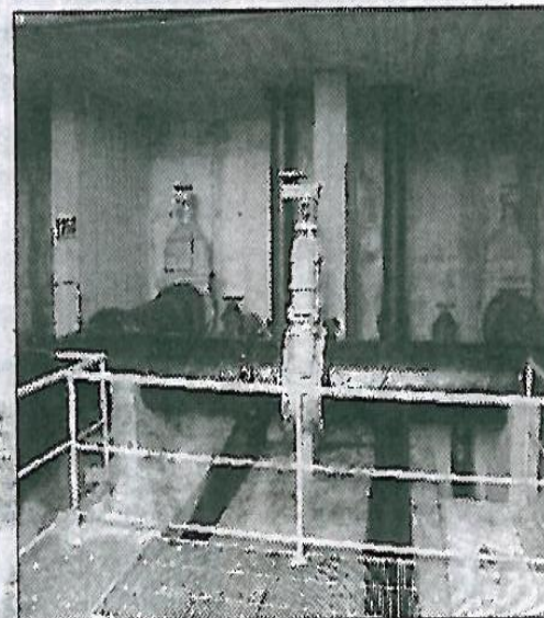
L'ingresso Il vecchio serbatoio
